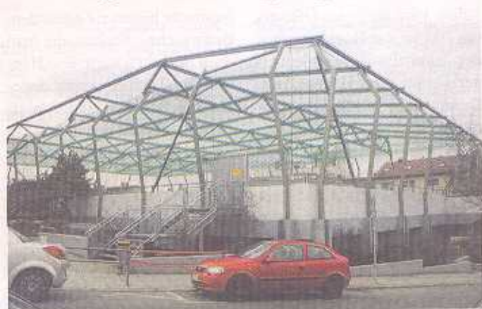
Stahlträger und Netze gegen fliegende Bälle
